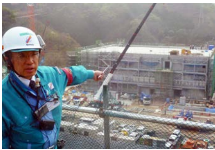
島根原発で建設中の重要免震棟。災害時の司令塔です。
